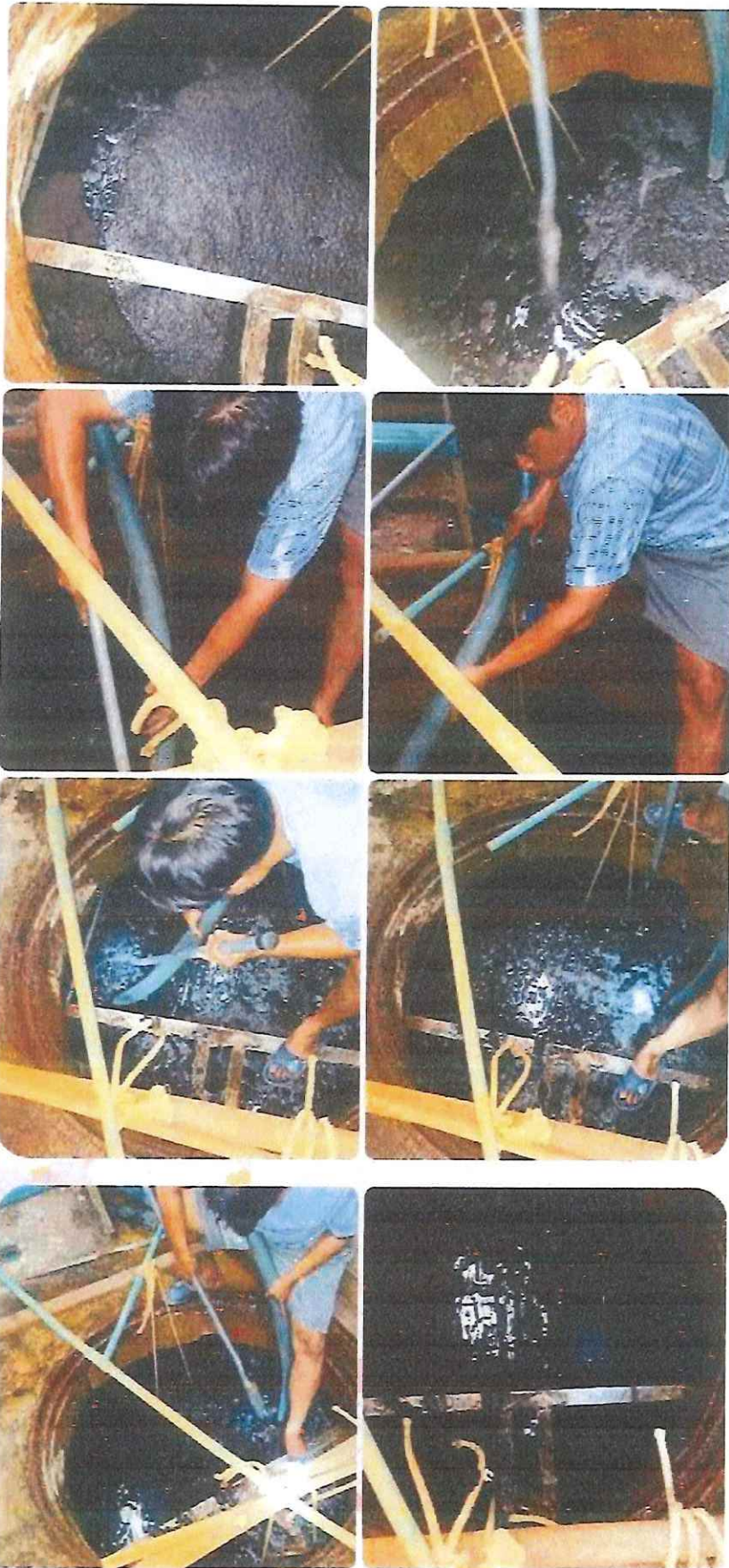
ภาพการทำงานสูบน้ำ SLUDGE ครั้งที่ 12 มิ.ย. โรงแรม Marriott Sukhumvit 24
