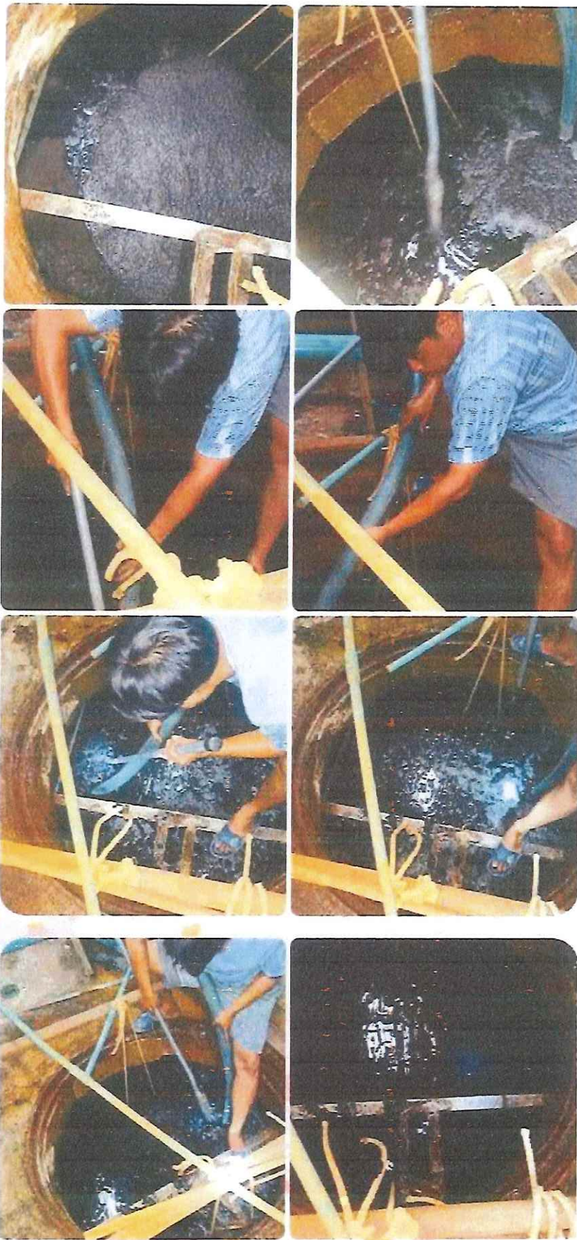
ภาพการทำงานสูบน้ำ SLUDGE ครั้งที่ 12 นิ.ย. โรงแรม Marriott Sukhumvit 24
